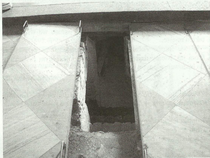
Wejście do krypty pod kaplicą Krzyża św.
